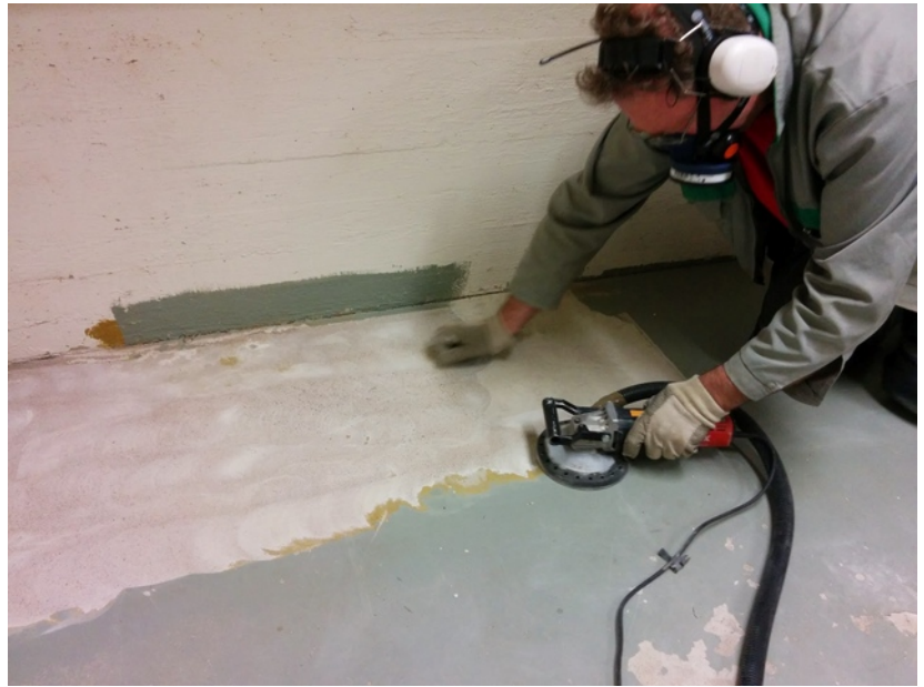
Väestönsuojan lattia hiottiin ja maalattiin uudelleen, työn touhussa Markku OH2FDA.
