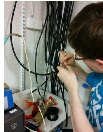
Ismo OH2FTG päättämässä uusittuja antennikaapeleita.
